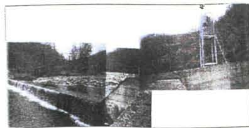
STAZIONE FLUVIALE - SETTA "DA D'ONOFRIO"
