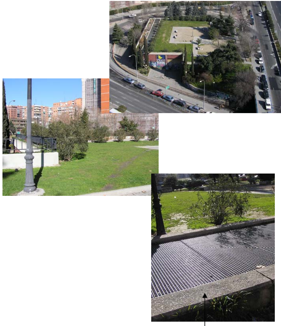
Rejilla de ventilación de la subestación
