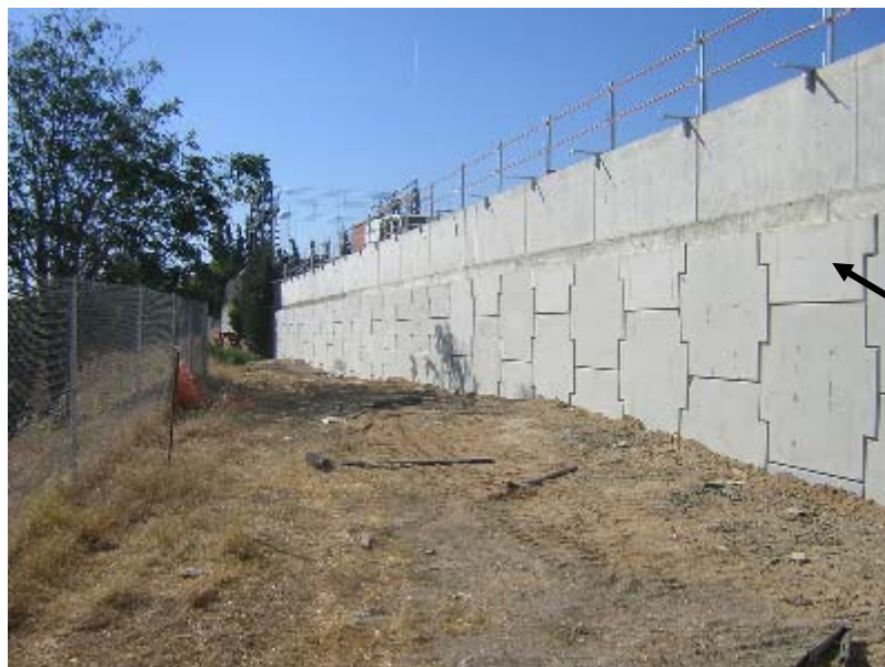
DETALLE DEL MURO PERIMETRAL POR EL LADO ESTE DE LA FUTURA SUBESTACION
