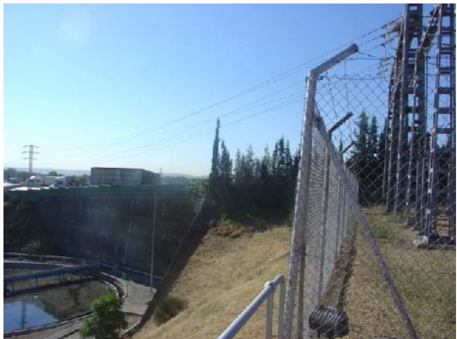
VISTA DE LA PARCELA DESDE LA ESQUINA NORESTE JUNTO A LA EDAR
