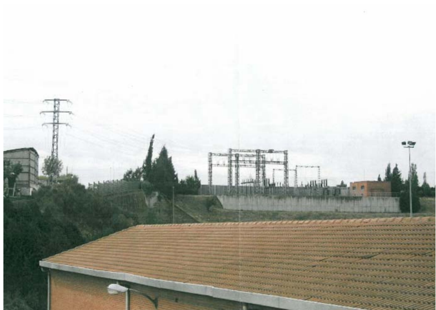
VISTA DE LA SUBESTACIÓN DESDE LA EDAR DE BUTARQUE
