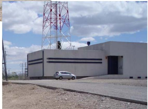
Se trata de un edificio de dos niveles la planta baja, donde se instalan las celdas, y un sótano para el tendido de cables de potencia, transformadores de servicios auxiliares y baños. También está dotado de instalaciones auxiliares, salas de mando y depósitos.
