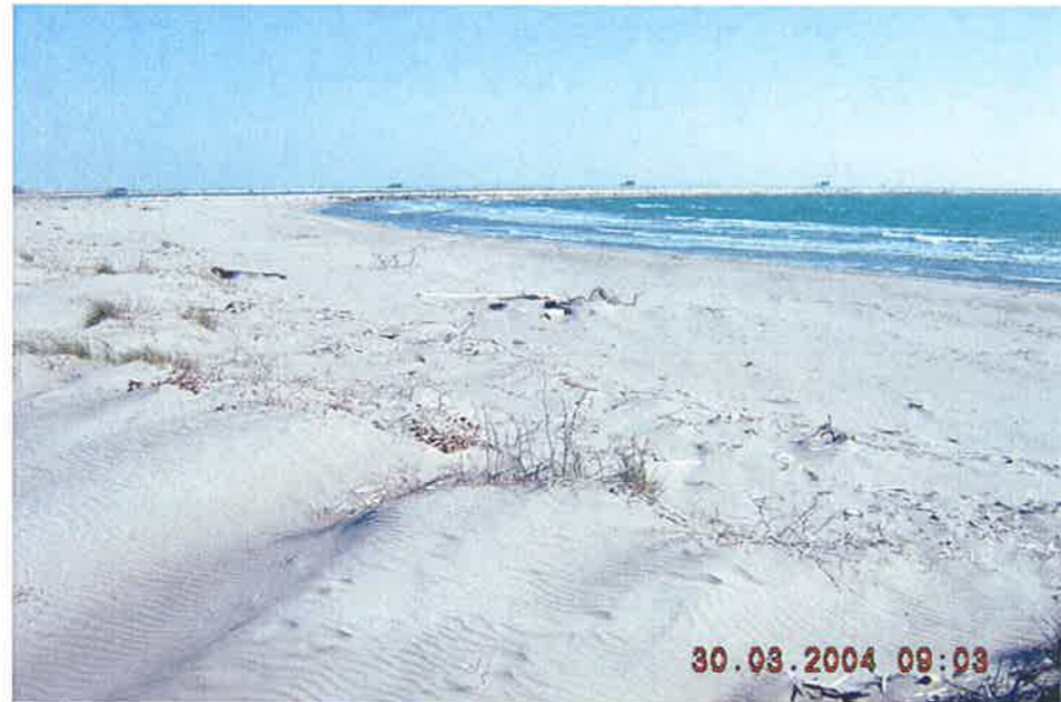
Figura 22: l'area di cantiere in radice del molo sud della bocca di Malamocco
