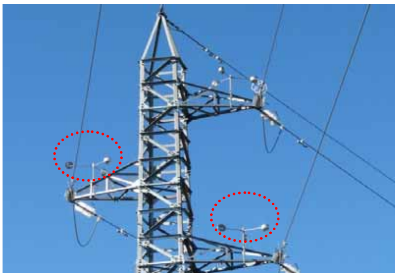
↑ Perchoirs positionnés à environ 50 cm au-dessus des conducteurs
