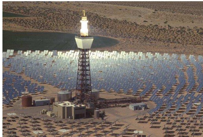
Ilustración nº 2. Campo de helióstatos de la Central Solar Two (California)
