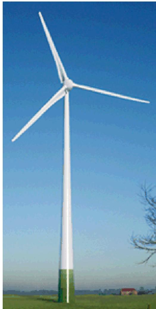
**Slika 3.4** Tipična 2 MW vjetroturbina Enercon E-82
