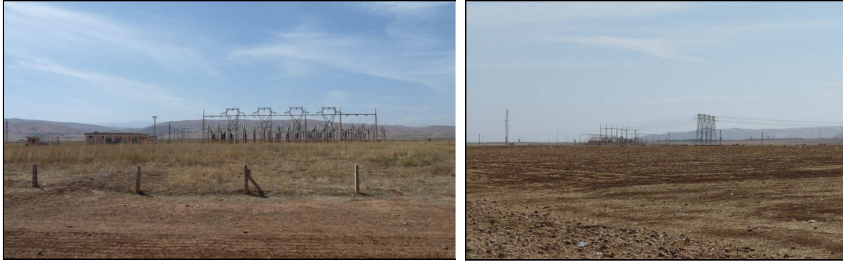
Photo 3 : Poste de Tazarte
