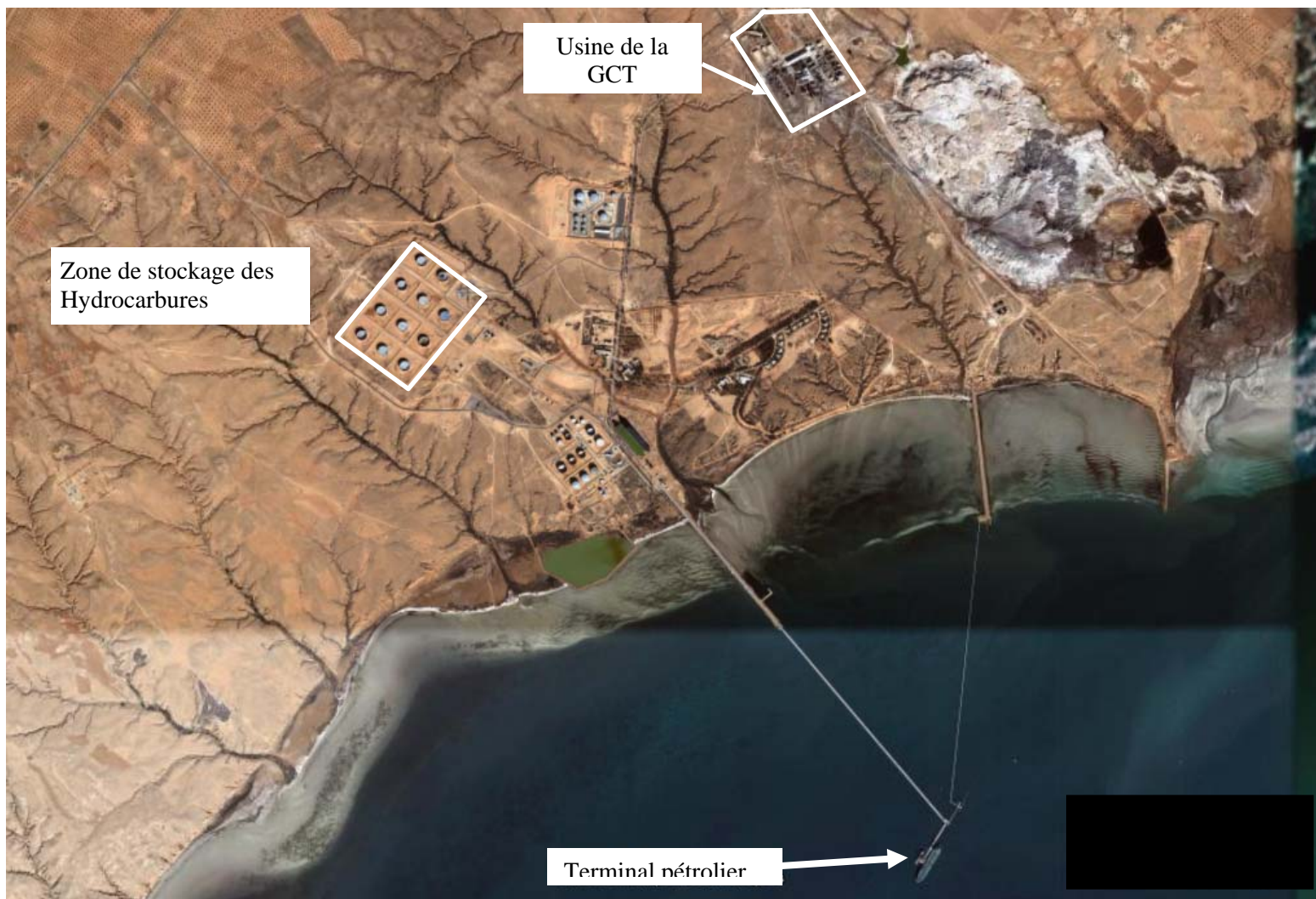
Figure 4444 : Zone industrielle de la Skhira
