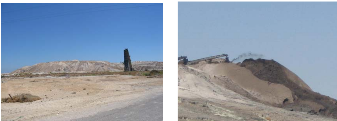
Figure 58585858 : La tabia de phosphogypse existante
