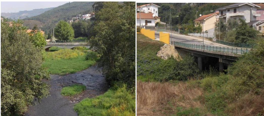
Figura 3.2-1. Rio Ferreira, junto à localidade de Mó (à esquerda), ponte sobre o rio Ferreira na qual será instalada a adutora (à direita)
