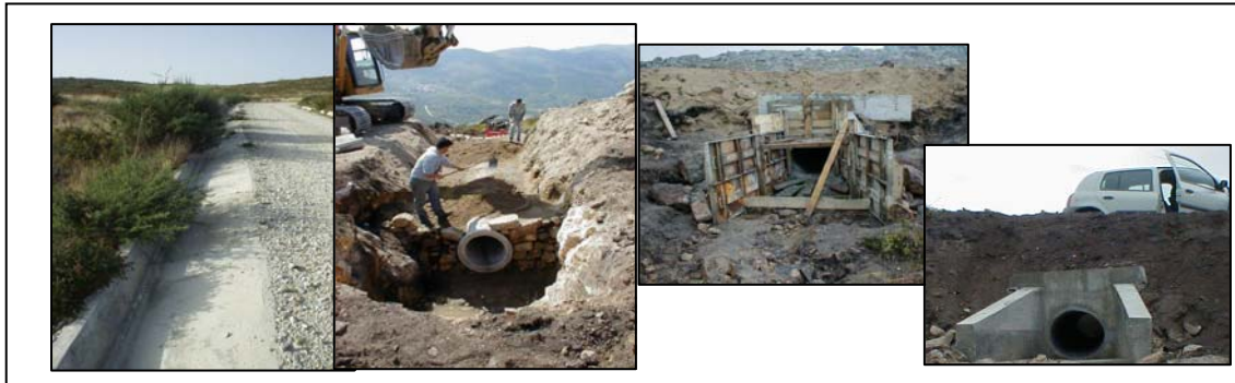
Figura 7 – Valeta e construção de uma passagem hidráulica.
