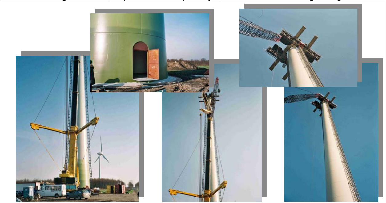
Figura 10 – Montagem da torre de um aerogerador.
