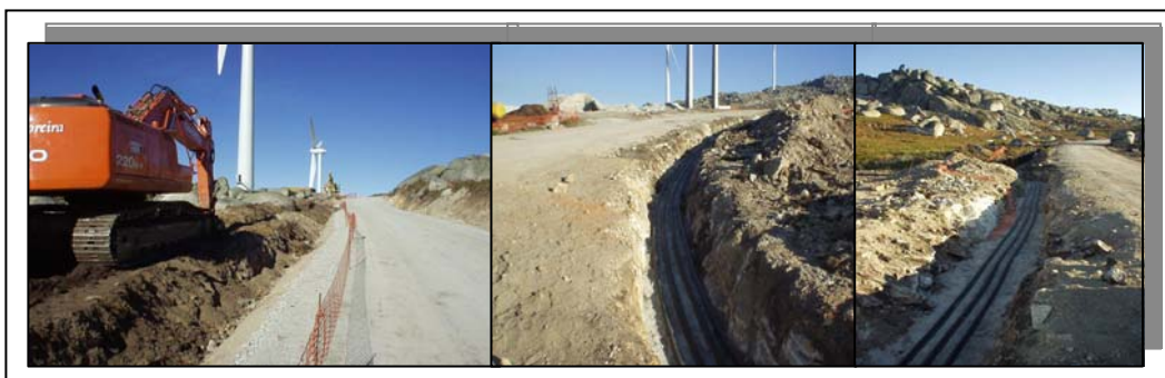
Figura 12 – Vala para instalação dos cabos eléctricos subterrâneos.
