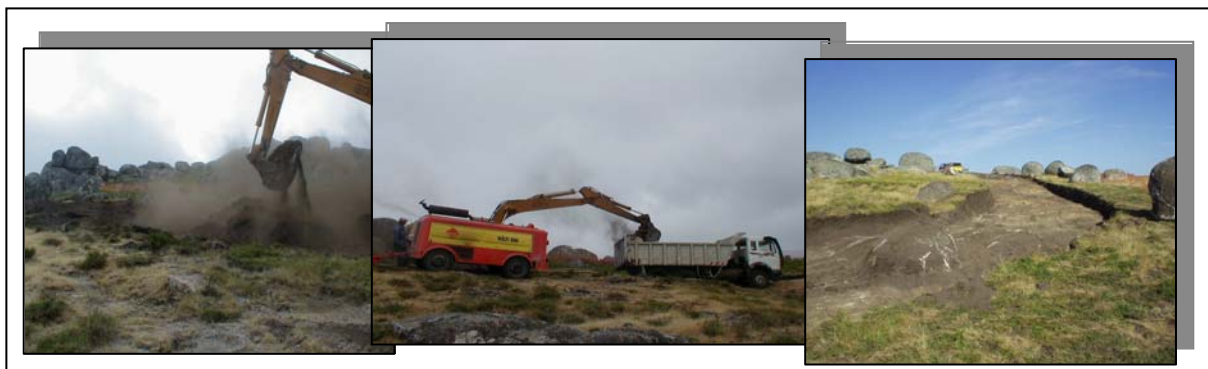
Figura 6 – Abertura de um caminho de acesso.
