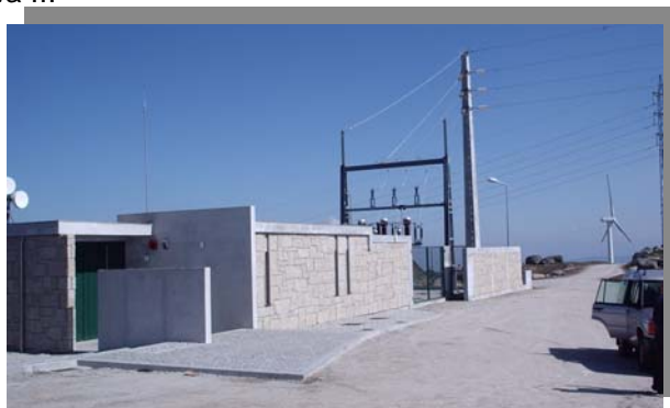
Figura 5 – Exemplo de um edifício de comando/subestação de um parque eólico existente.
