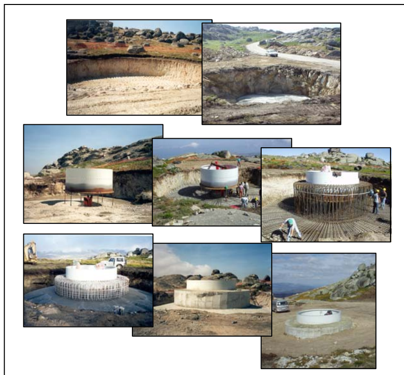
Figura 8 – Execução da fundação da torre de um aerogerador.
