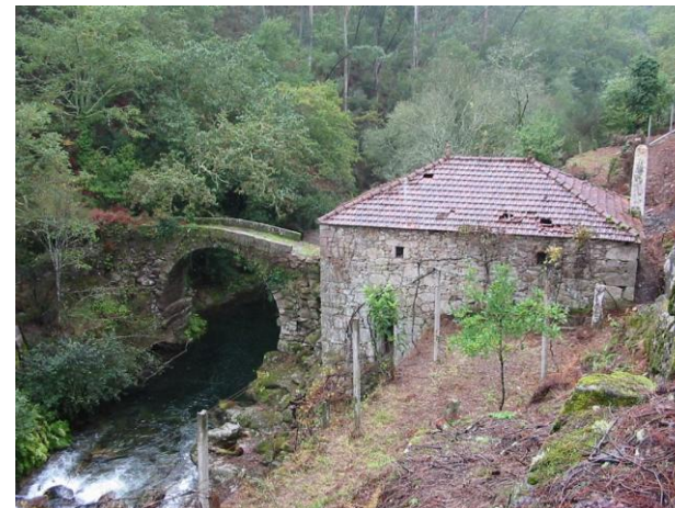
Ponte e moinho localizados na área a inundar pela albufeira de Merufe
