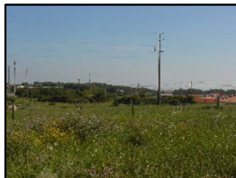
3 – Linhas de alta tensão existentes no local proposto para a implantação da FS
