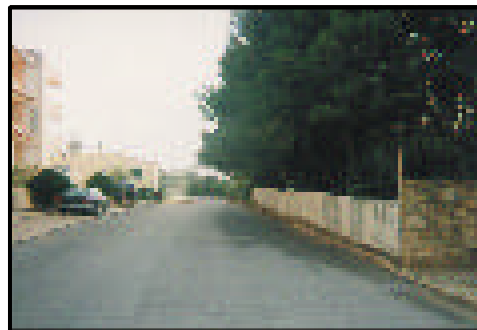
2 – Perspectiva da limite nascente do local proposto para a implantação da FL (Vista para Sul)
