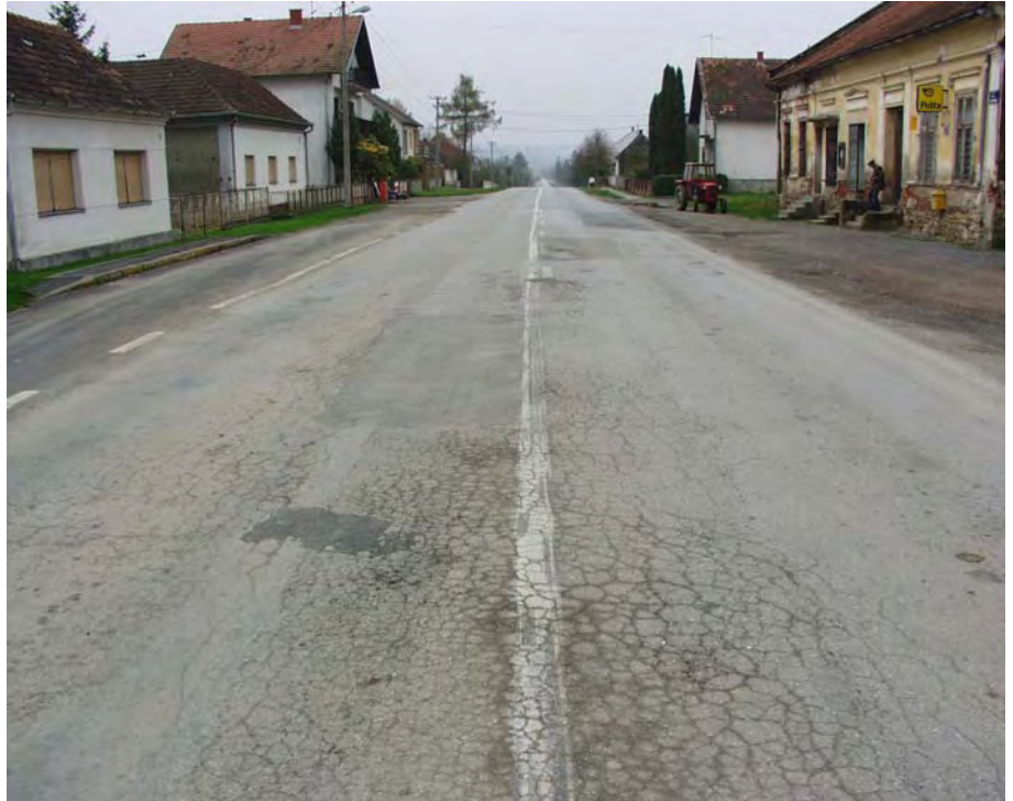
Sl. 21 km 10+000.00 dionica kroz naselje Badljevina
