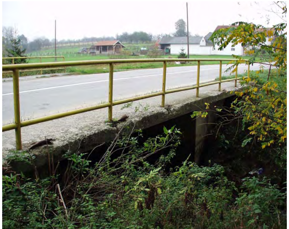
Sl. 19 Propust u naselju Badljevina
