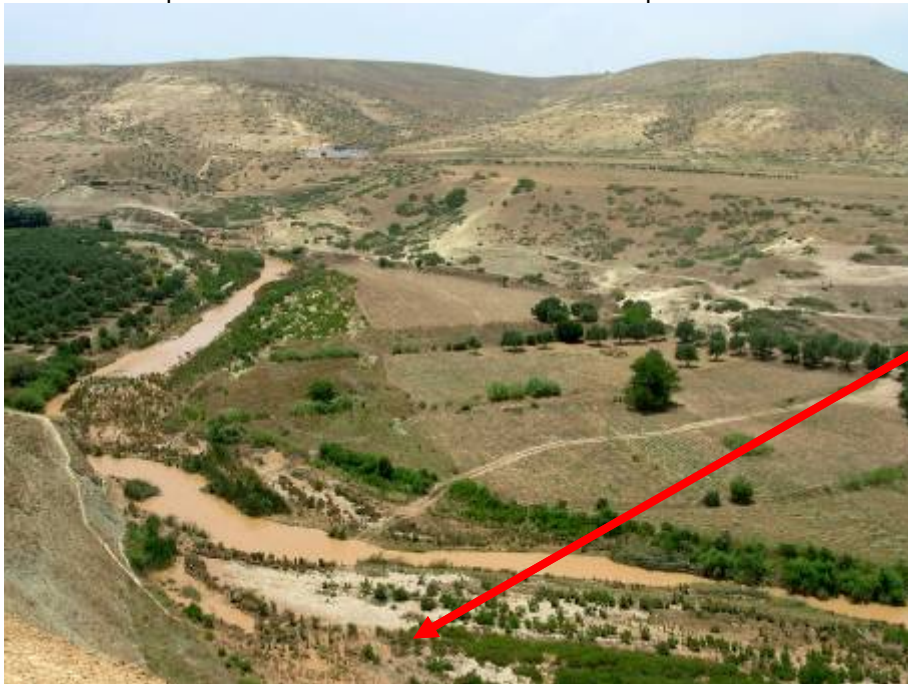
Tronçon Fès-Taza : Traversée du Sebou au PK 35 + 500
