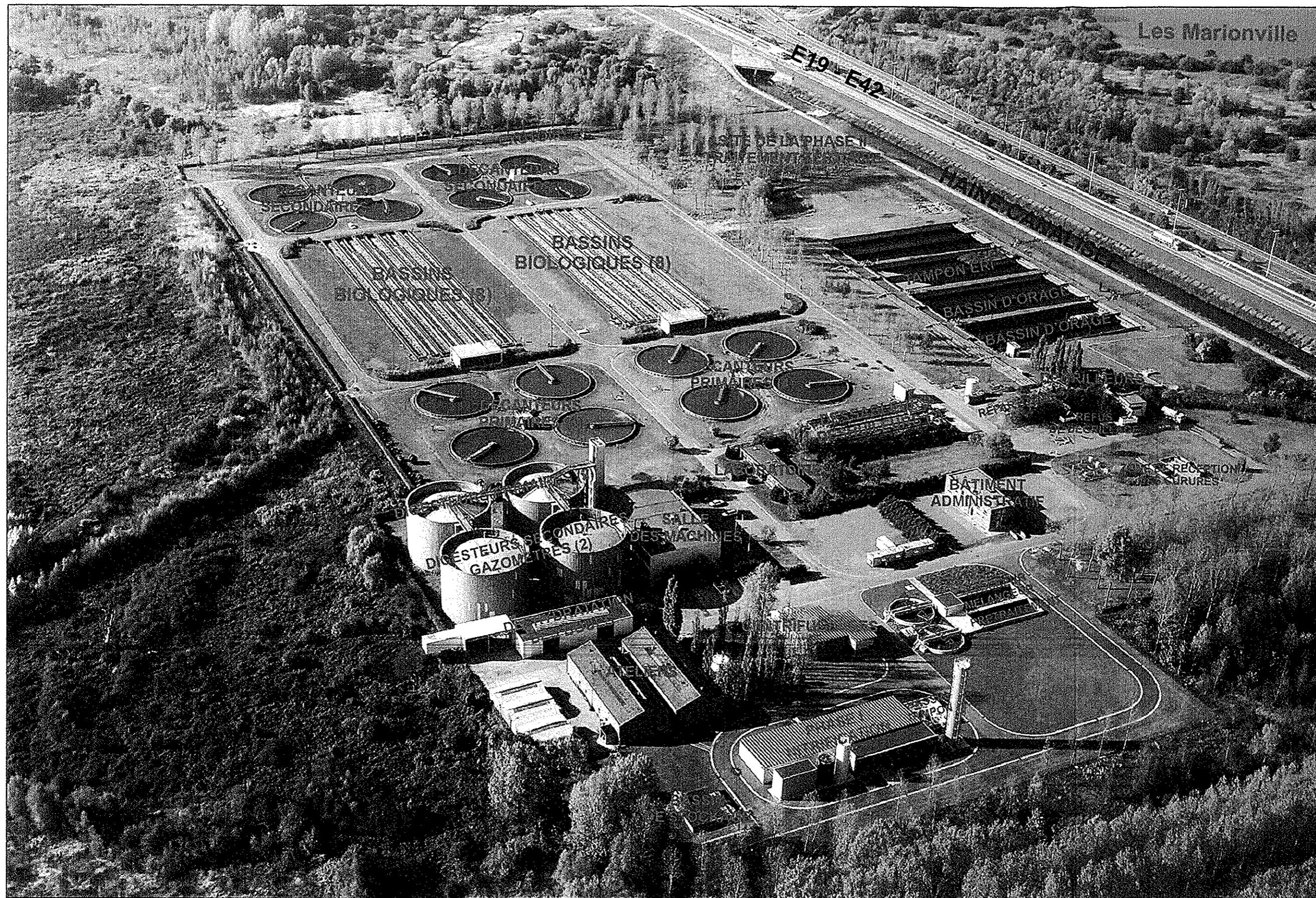
Photo 4 : vue aérienne de la station de Wasmuel (avant la réalisation de la phase II)
