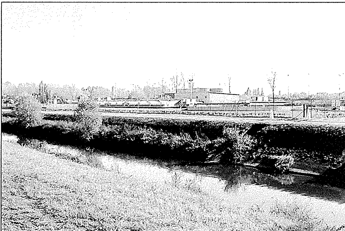
photo 3: vue de la station d'épuration depuis l'autoroute E19-E42 dans le sens Paris-Mons
