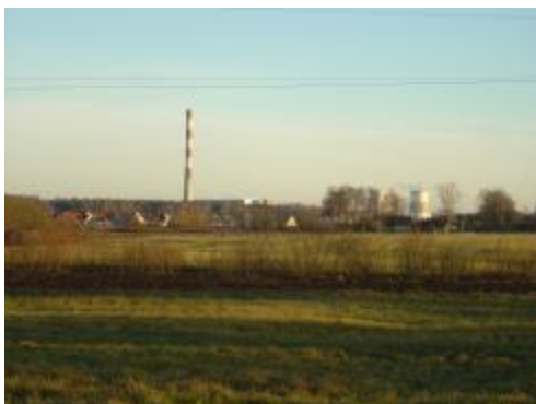
2.2.7.3. attēls. Skats uz TEC – 2 teritoriju no ziemeļu puses.
