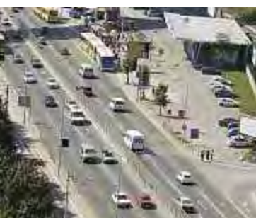
Remise en état du réseau routier, Serbie
