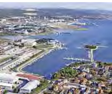
Infrastructure portuaire, Croatie
