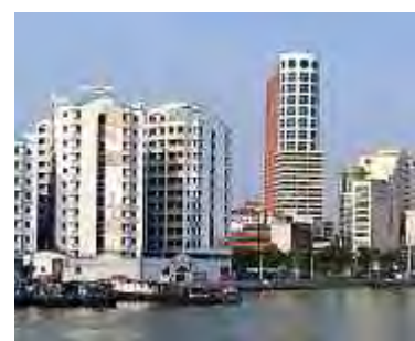
Réseau de distribution d'eau, Philippines
