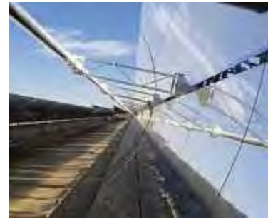
Collecteurs de la centrale thermosolaire, Grenade
