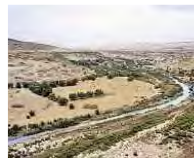
Construction de l'autoroute, Fès - Oujda, Maroc
