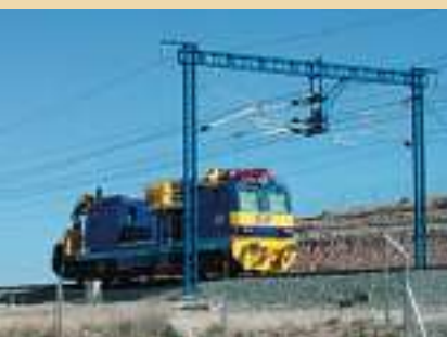
Construction d'une ligne à grande vitesse, Madrid-Barcelone
