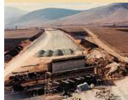
Construction d'une autoroute, axe Egnatia
