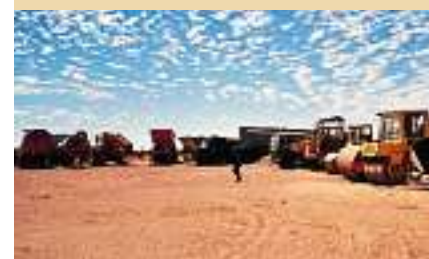
Construction de routes, Mauritanie
