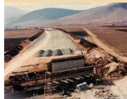
Bau einer Autobahn auf der Egnatia-Achse
