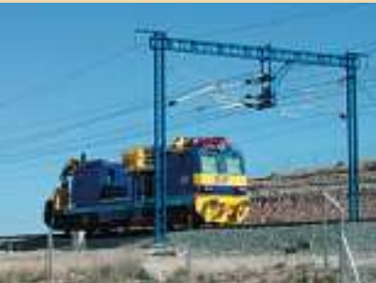
Bau einer Hochgeschwindigkeits-Eisenbahnstrecke zwischen Madrid und Barcelona
