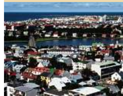
Abwasserbeseitigung in Reykjavik
