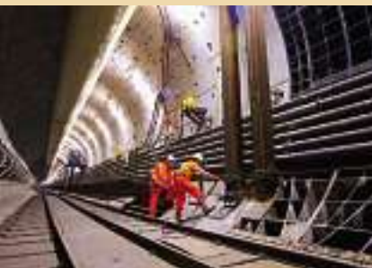
Eisenbahntunnel östlich von London
