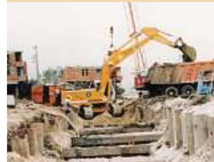
Wiederaufbauarbeiten in der Türkei
