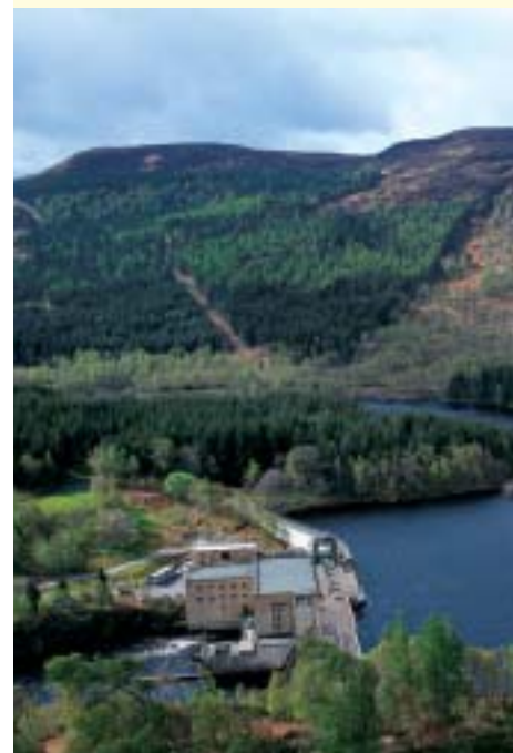
Wasserkraftwerk, Torrachilty (Schottland)
