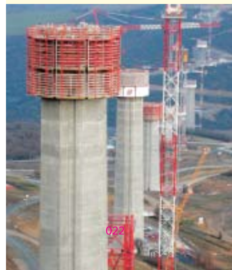
Baustelle des Viadukts von Millau im Département Aveyron
