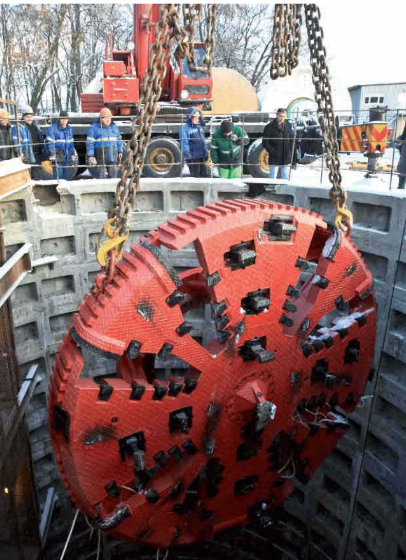
Galvenā kolektora būvniecība, Sanktpēterburga, Krievija
