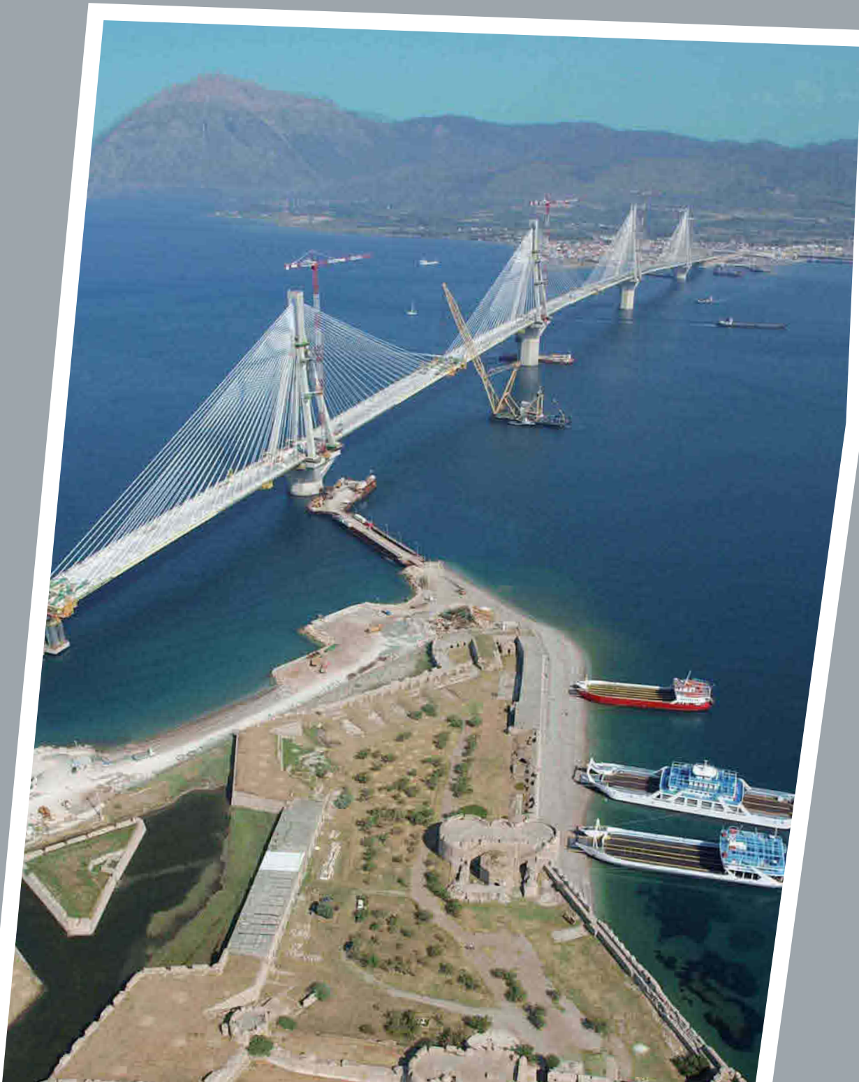
Korintinlahden salmen ylittävä Rion-Antirion silta, Kreikka
