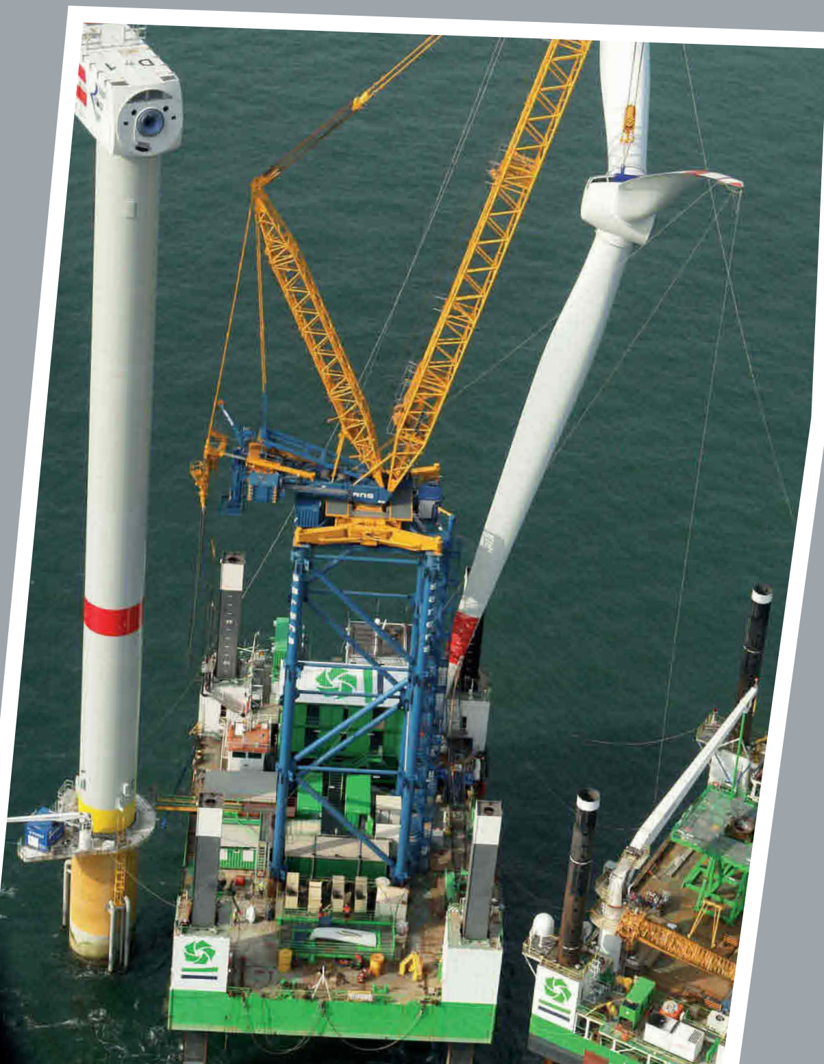
Tuuliturbiinia asennetaan merelle, Belgia
