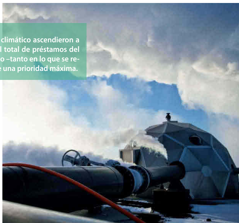
Complejo de energía geotérmica de Hellisheidi, Islandia
