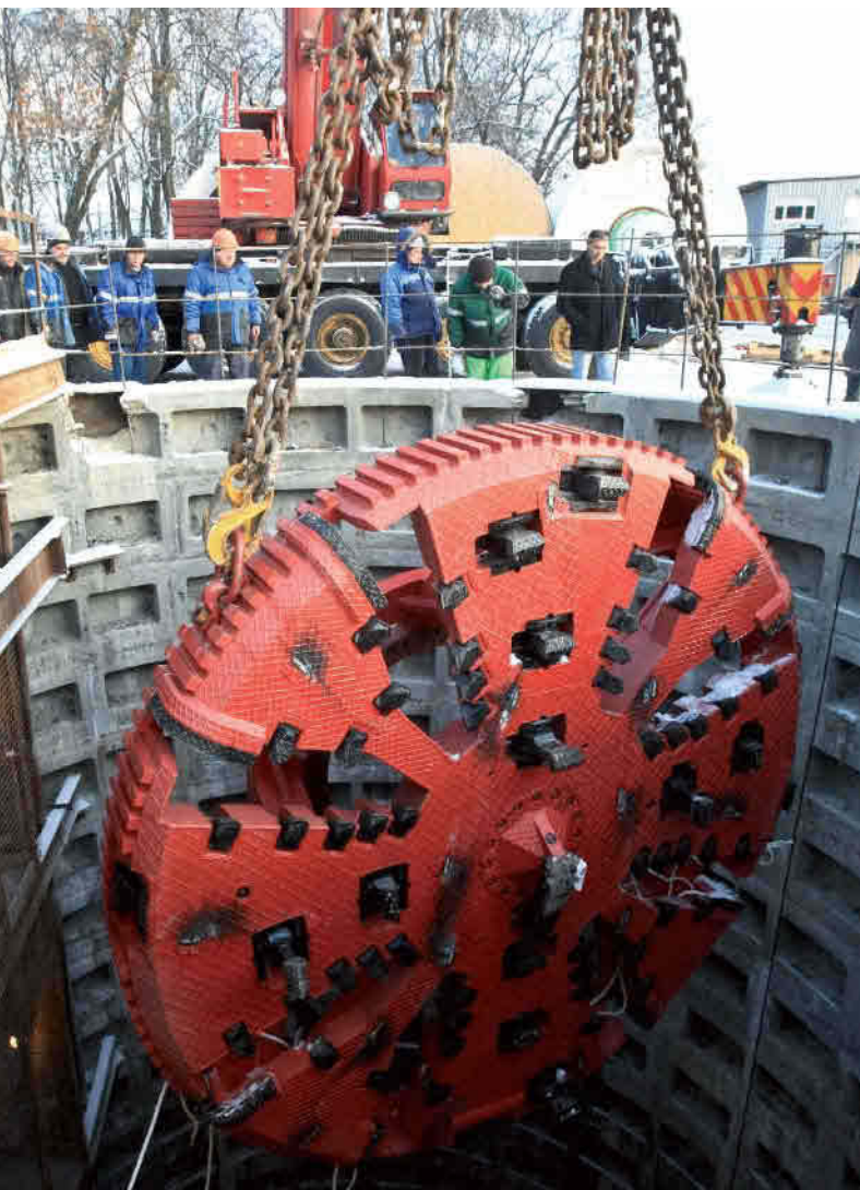
Construcción del colector principal en San Petersburg, Rusia
