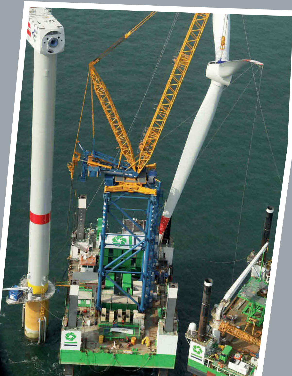
Instalación en el mar de un generador eólico, Bélgica
