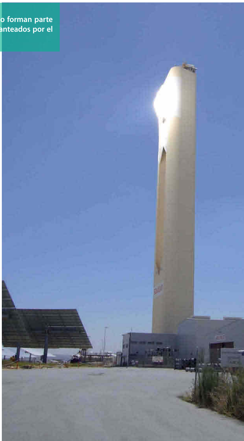
Torre de la central eléctrica de Solucar, España
