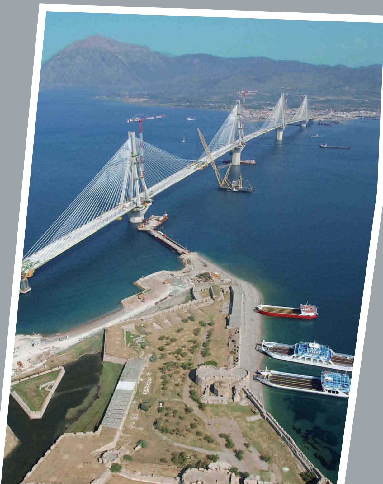
Puente Rion-Antirion sobre el golfo de Corinto, Grecia
