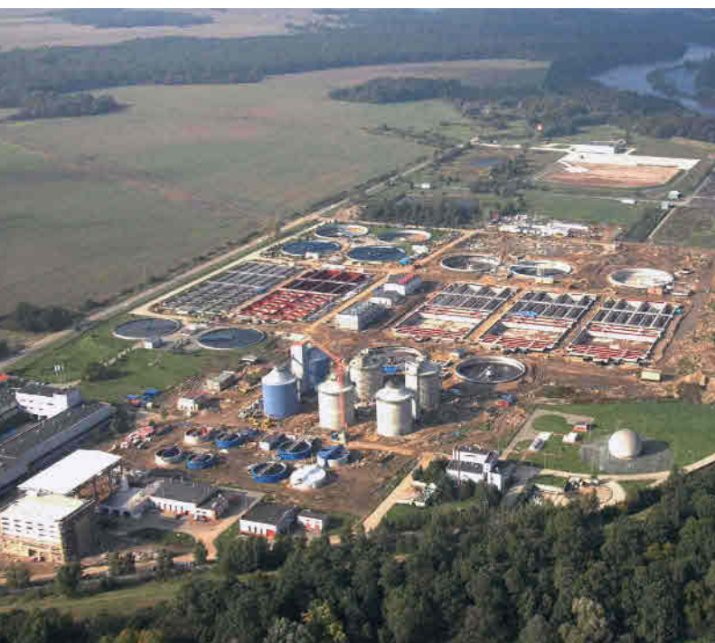
Obras en el sector del agua en Wrocław, Polonia
