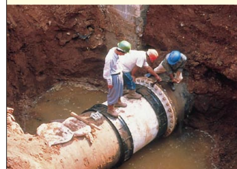
Costruzione di un gasdotto
