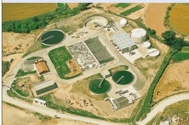
Impianto di depurazione nei pressi di Barcellona
