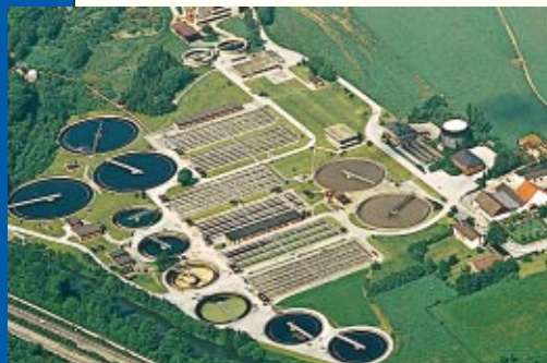
Impianto di depurazione a Wuppertal
