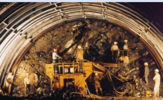
Κατασκευή του μετρό Αθηνών
