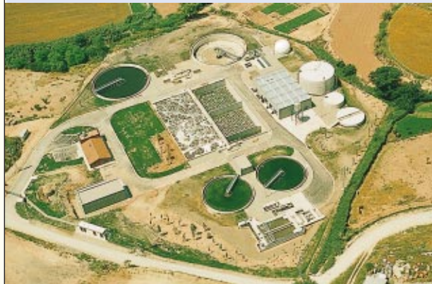
Σταθμός καθαρισμού λυμάτων κοντά στη Βαρκελώνη
