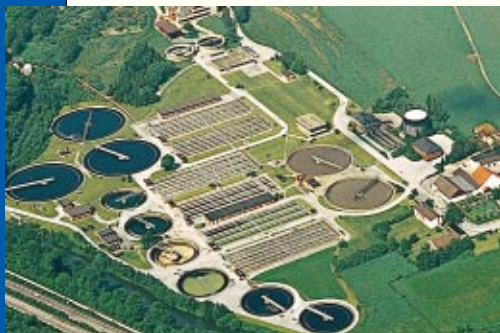
Σταθμός καθαρισμού λυμάτων στο Wuppertal
