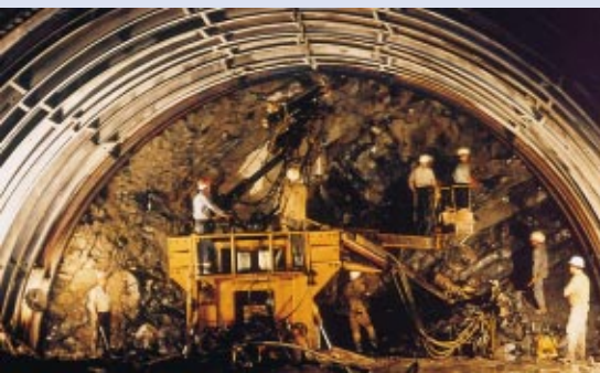
Opførelse af Athens metro
