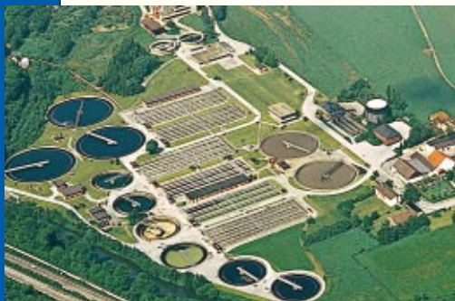
Renseanlæg i Wuppertal
