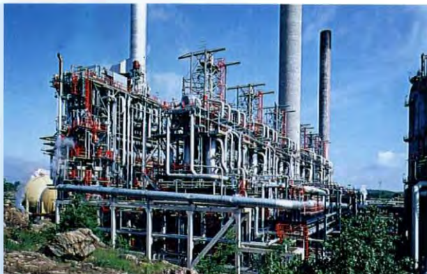
Εργοστάσιο πετροχημικών κοντά στο Göteborg
