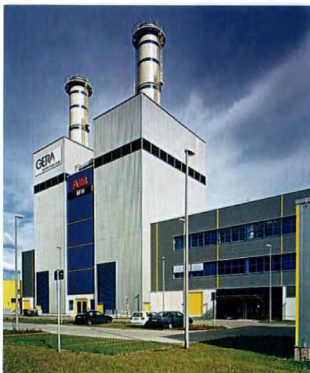
Σταθμός συμπαραγωγής τροφοδοτούμενος με αέριο στη Gera
