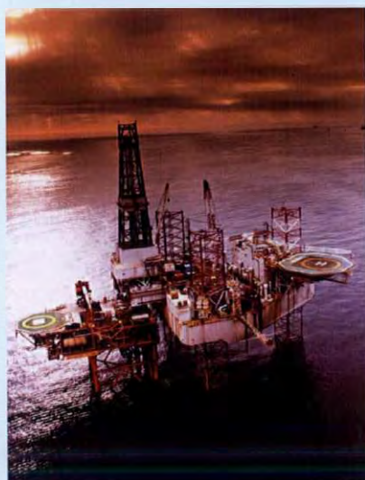
Αξιοποίηση του κοιτάσματος πετρελαίου και αερίου του Erskine, στη Βόρεια Θάλασσα
