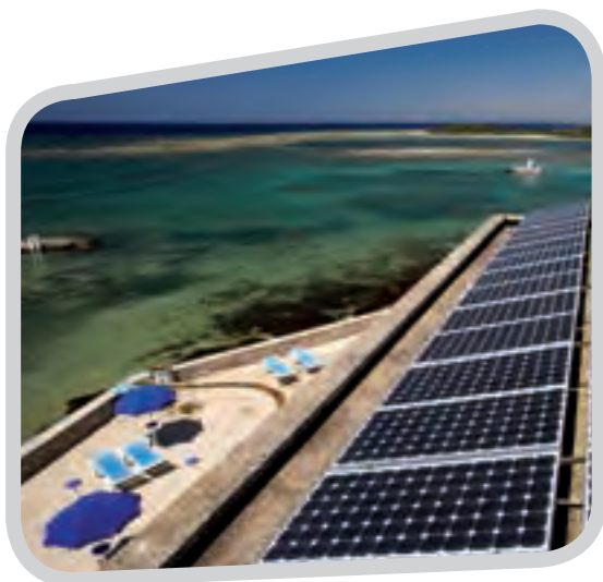
ENEL Greenpower Energie Rinnovabili II Italie Décaissement OCR : 36 millions d'EUR
