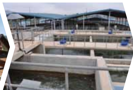
Satisfação da procura crescente de água no Uganda (2011)
