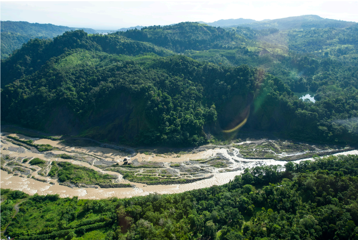
(Restos del Dique después de la crecida del río)
