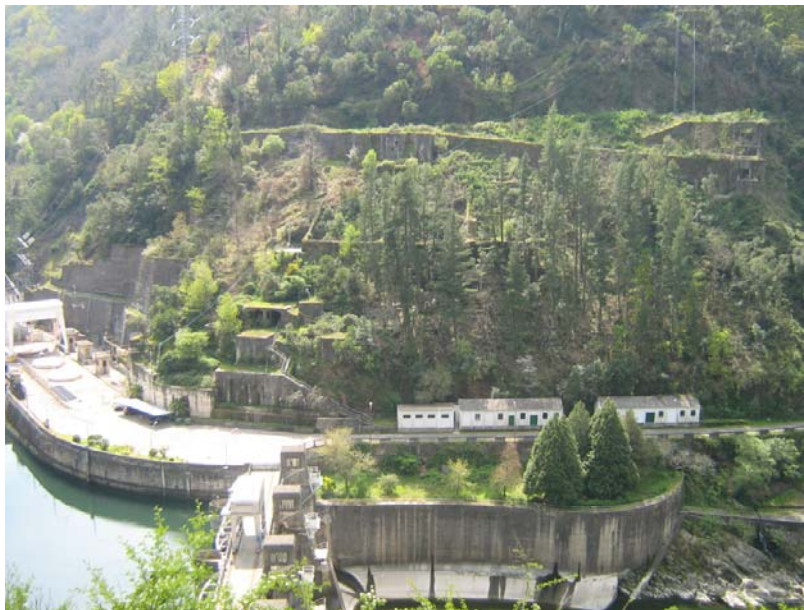
Vista, desde la carretera CP 41-04 que discurre por la margen derecha entre Os Peares y Pombeiro, de las instalaciones asociadas a la Presa de San Pedro.
