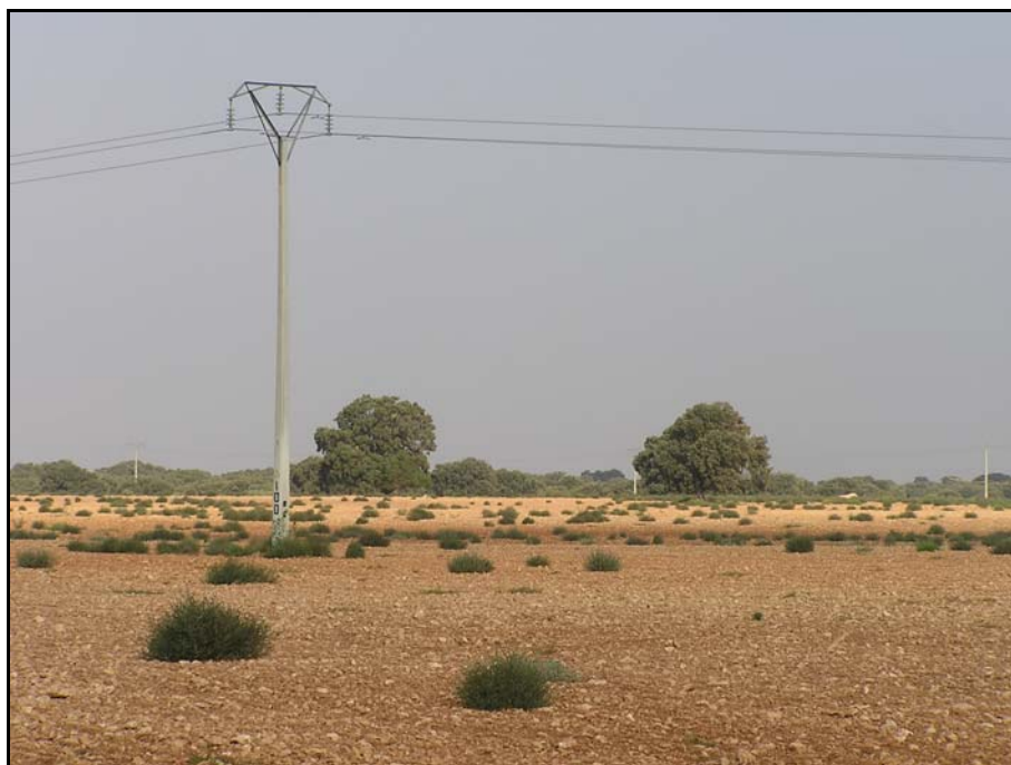
Foto 2. Tendido eléctrico de baja tensión que cruza el sector proyectado para la ubicación de la Planta Termosolar Manchasol-1.
