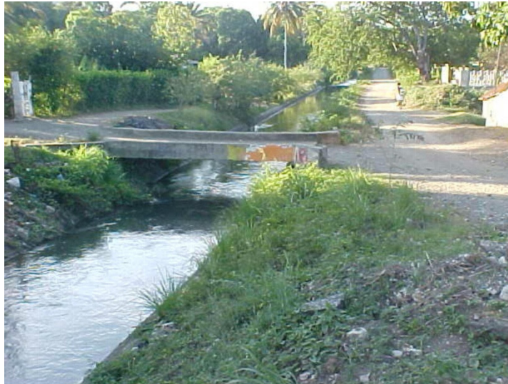
BERMA DEL CANAL DE RIEGO SANTANA
