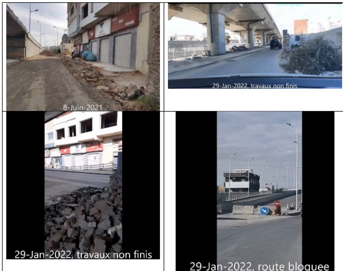
Figure 1 – Photos des travaux le long de la chaussée
